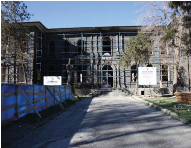
Proje öncesi Adliye B Binası
