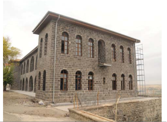
Proje sonrası Adliye A Binası
